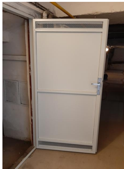
pohled dveře z vnitřní strany
