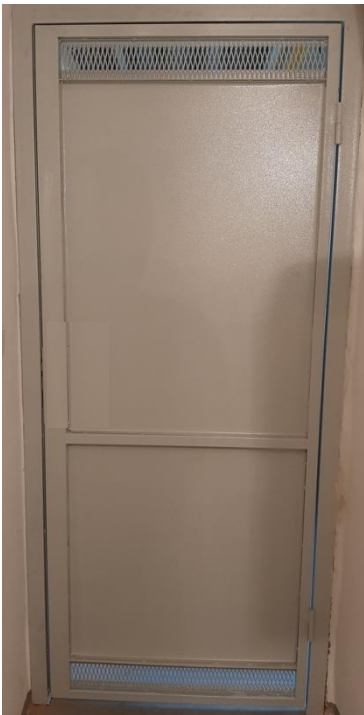
pohled zvnitř kóje na nové dveře ( jednostranné plechové opláštění dveří s odvětrávání )
