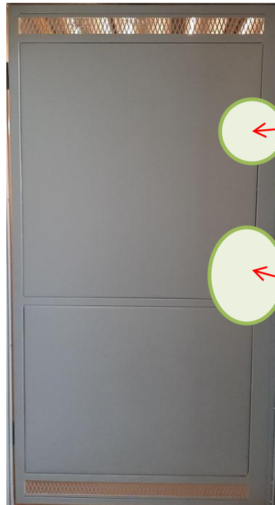
pohled zvenčí kóje na nové dveře umístění zámku FAB s vyvařeným pouzdrem a oky na visací zámek
